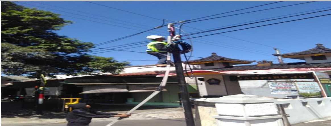
PROGRESS PENURUNAN SLACK KABEL FO
