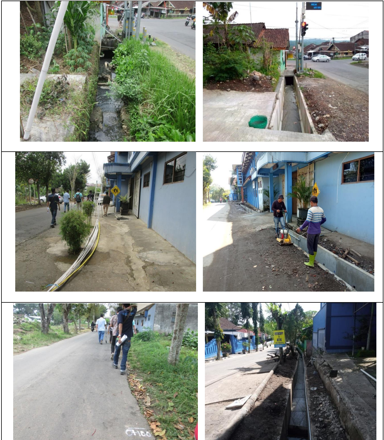
DOKUMENTASI PEKERJAAN PEKERJAAN PEMBANGUNAN DRAINASE JALAN SUNDORO FOTO 0% 100%
