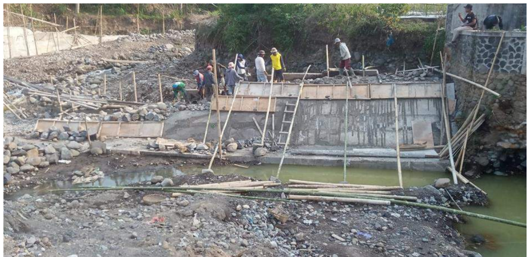
Gambar 3.19 Rehabilitasi Jaringan Irigasi Desa Karangtejo Kecamatan Jumo Kabupaten Temanggung (Bankeu Provinsi Jawa Tengah 2023)
