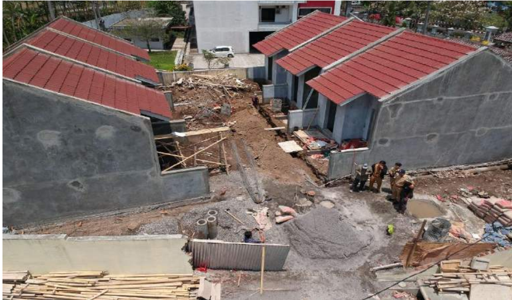
Gambar 3.20 Pembangunan Rumah Dinas Jaksa
