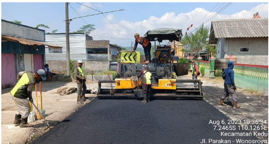
Gambar 3.21 Penanganan Long Segment Jalan Parakan - Wonosroyo (DAK)
